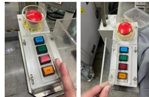
■ 臺灣總部操作開關區改善前/後
